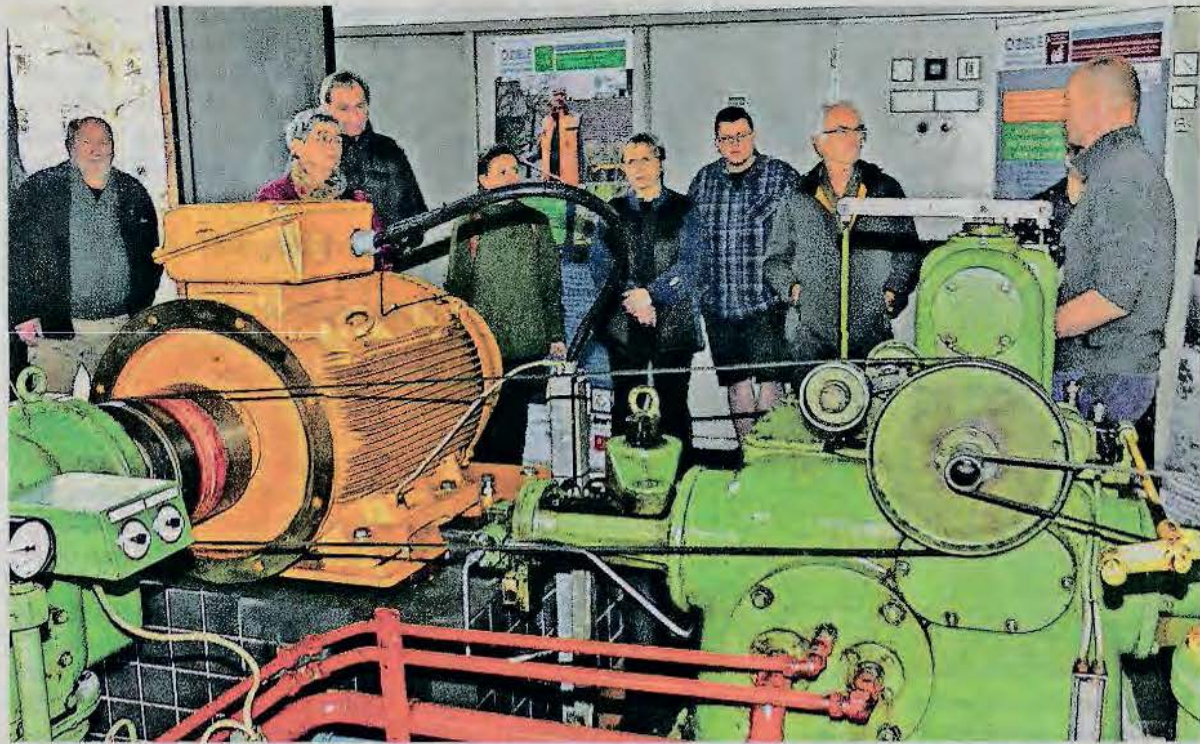
Im Wasserwerk der Gemeinde Höfen erläuterte Wassermeister Marko Hübner die Funktion des Getriebes, des Reglers und des Generators.
